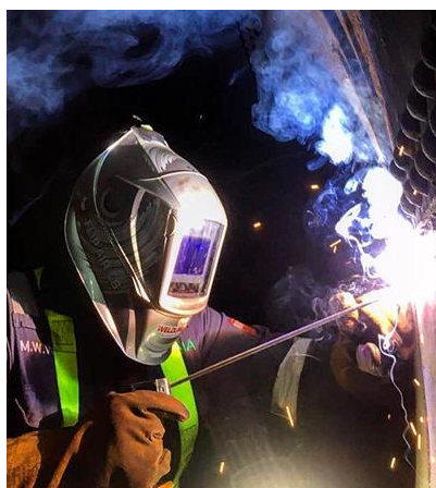
Grŵp Mona yn atgyweirio piblinellau
